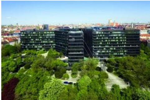
Die EPA-Gebäude in München
