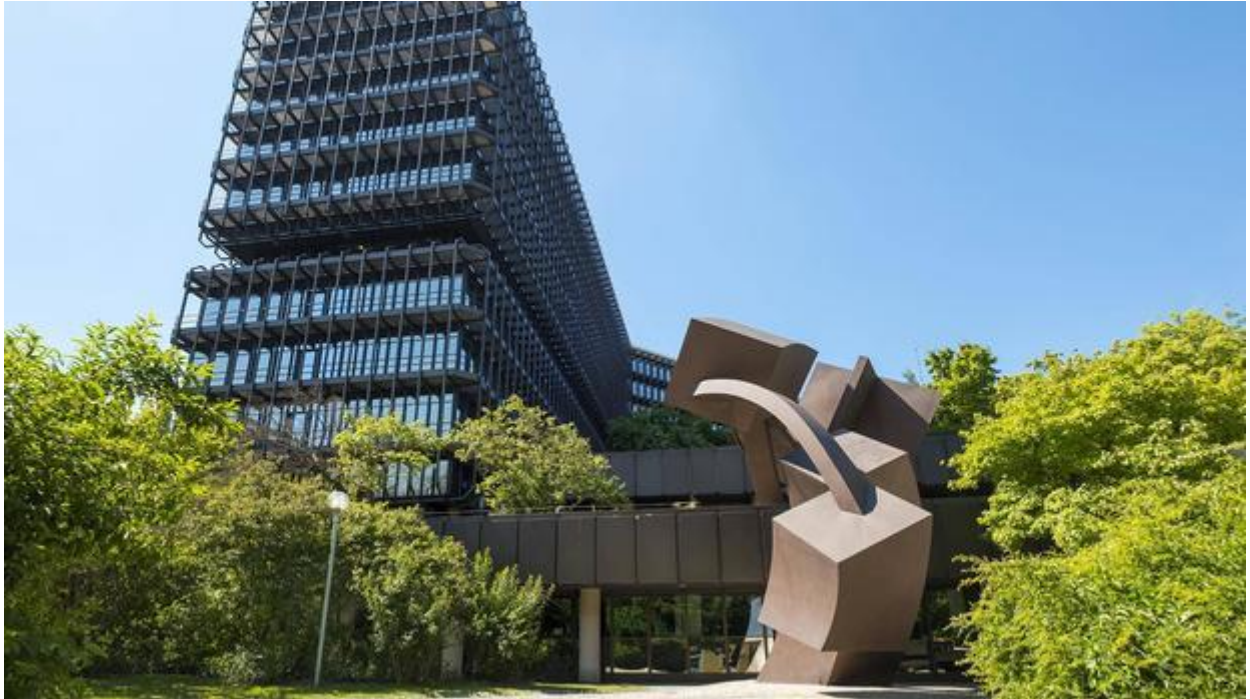
Le bâtiment principal de l'Office européen des Brevets à Munich. Photo : imago
