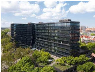
Chambres de Recours – retour à Munich ?
